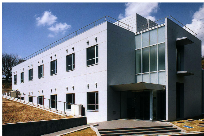
写真1 2001年3月に竣工した新実験棟
